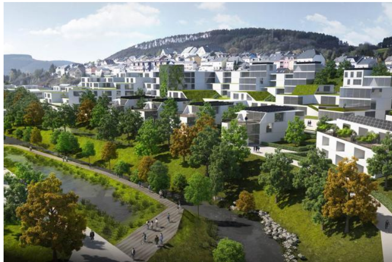
Le quartier comptera 780 nouveaux logements au 3e trimestre 2018.
